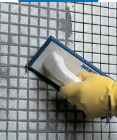
Заполнение швов в стеклянной мозаике (ванная комната) шпателем
