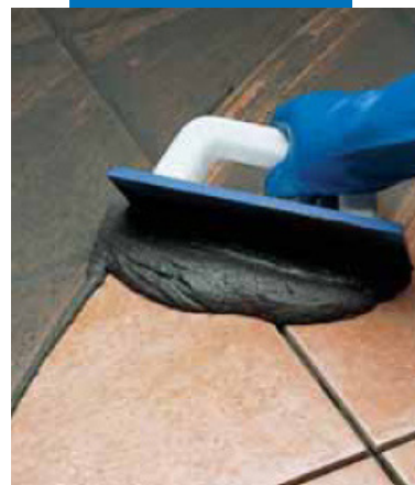
Заполнение швов в плитке на полу резиновым шпателем
