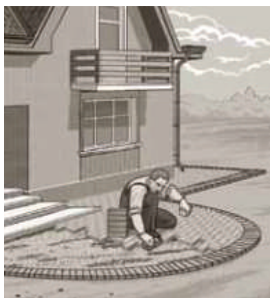
Укладка очередных рядов клинкерной брусчатки.
