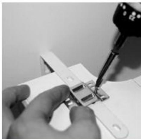
Установить карниз на кронштейн, используя металлическую накладку для крепления
