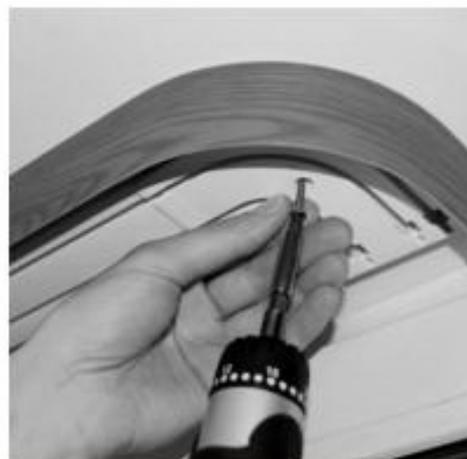
Закрепить карниз при помощи шурупов
