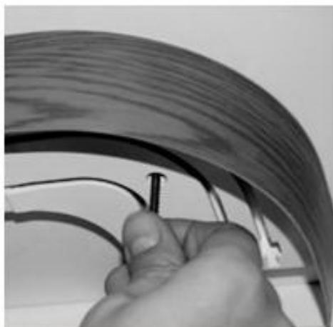
Сделать разметку крепления карниза (в шине предусмотрены монтажные отверстия)
