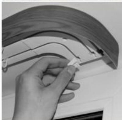
Установить стопоры на торцах шины
