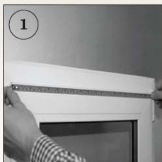
1 Сделать разметки крепления рулонной шторы.
