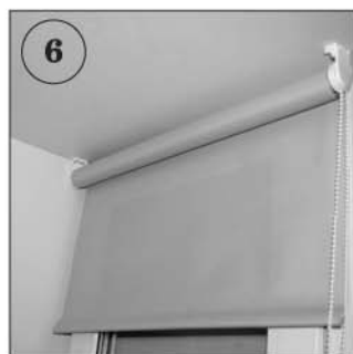
6 Открытая часть цепочного механизма должна быть направлена вниз.
