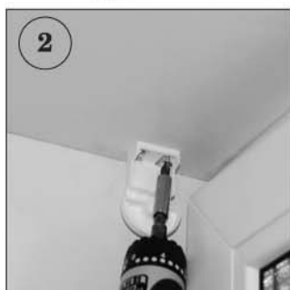
2 Установить кронштейны с помощью дюбелей и шурупов.
