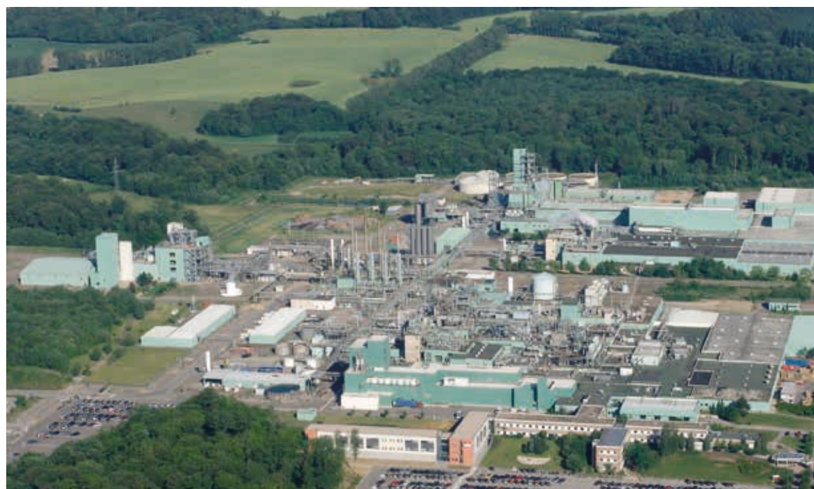
Производство Тураг®. Завод в Люксембурге.
