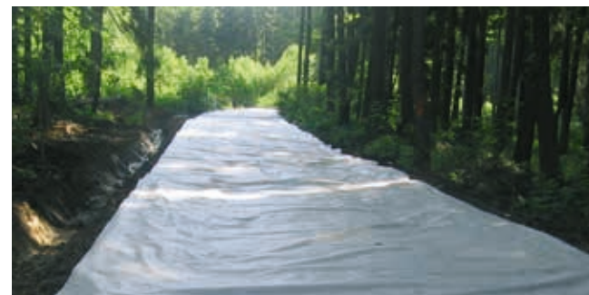
Строительство лесной дороги
