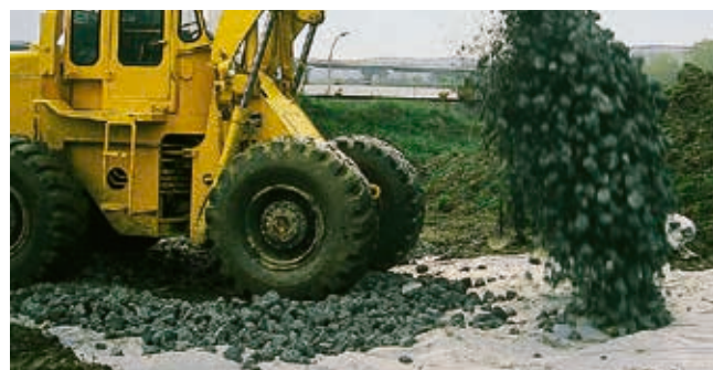
Turar® выдерживает высокие механические нагрузки во время укладки
