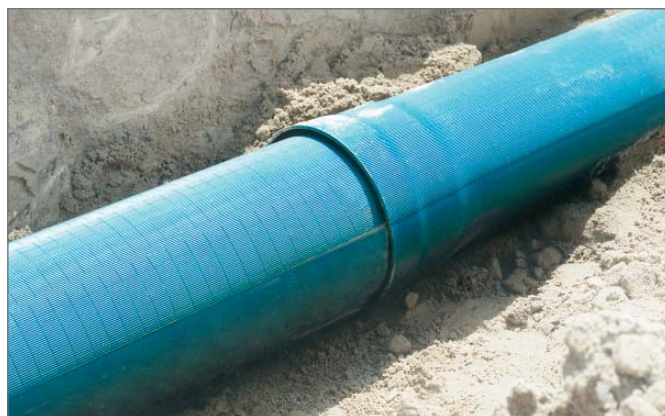
Рис. 9-33 Укладка дренажа на игровом поле
