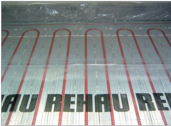
Рис. 3-59 Система укладки труб на теплоизоляционных матах TS-14
