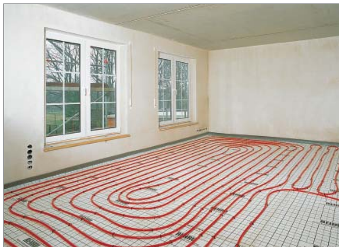
Рис. 3-22 Система крепления труб с помощью гарпун-скоб
