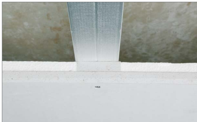
Рис. 4-6 Крепление потолочных панелей
