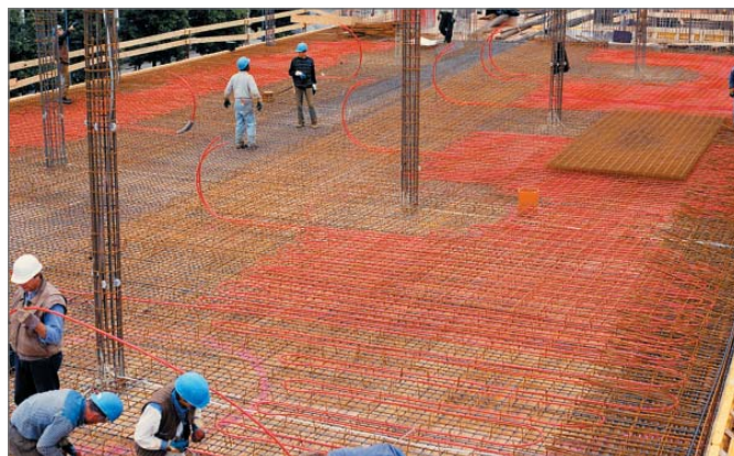
Рис. 8-5 Модули ВКТ RENAУ, укладываемые на месте
