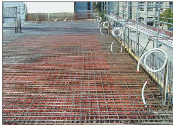
Рис. 8-2 Участок бетонирования ВКТ
