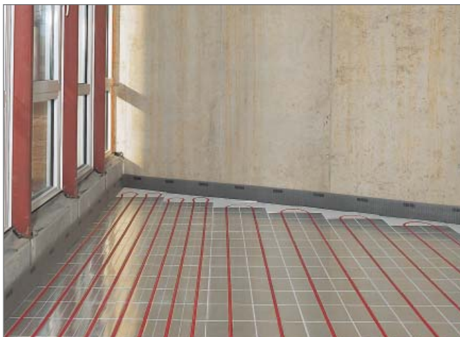
Рис. 3-49 «Сухая» система укладки труб
