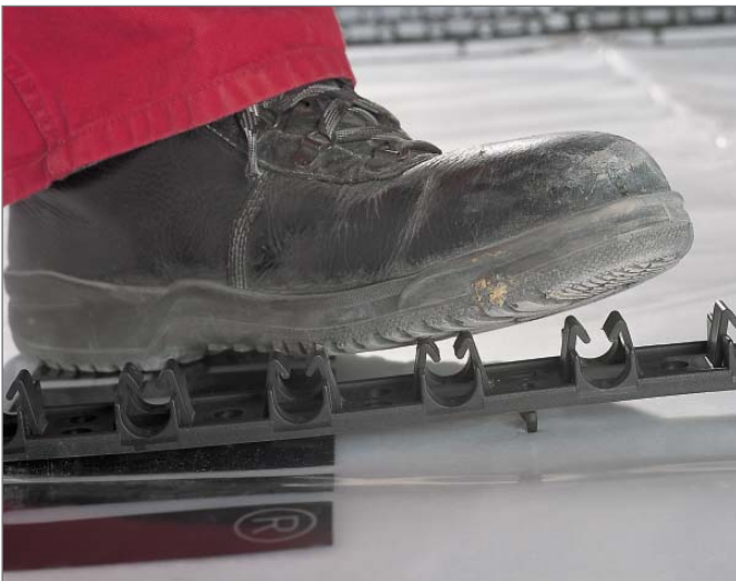
Рис. 3-34 Вдавливание фиксирующих шин RAUFIX в конструкцию пола
