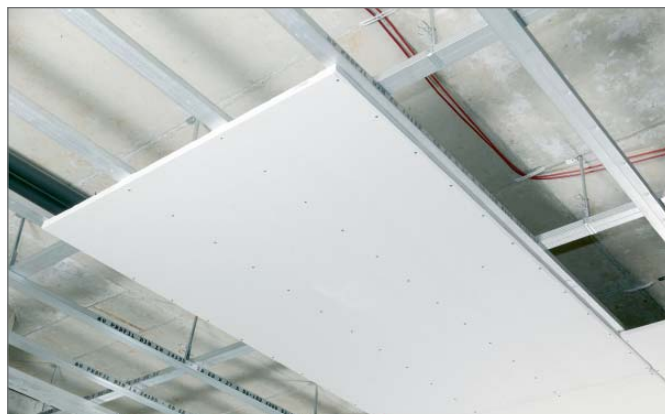
Рис. 4-5 Смонтированный потолочный элемент
