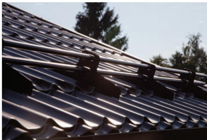
Принцип действия снегозадержателя – порционное пропускание снега и наледи между кровлей и трубками.
